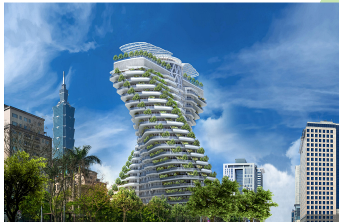
Projet « Agora Garden » de Vincent Callebaut en construction à Taïwan.
